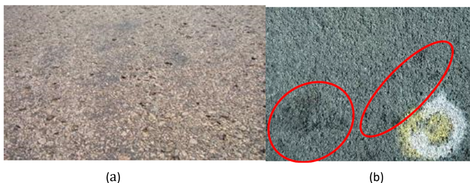
Figura 1: Perda de agregado nos estados do Ceará/Brasil e Carolina do Norte/USA, (a) Ceará (Loiola, 2009), (b) Carolina do Norte (Adams, 2014)
