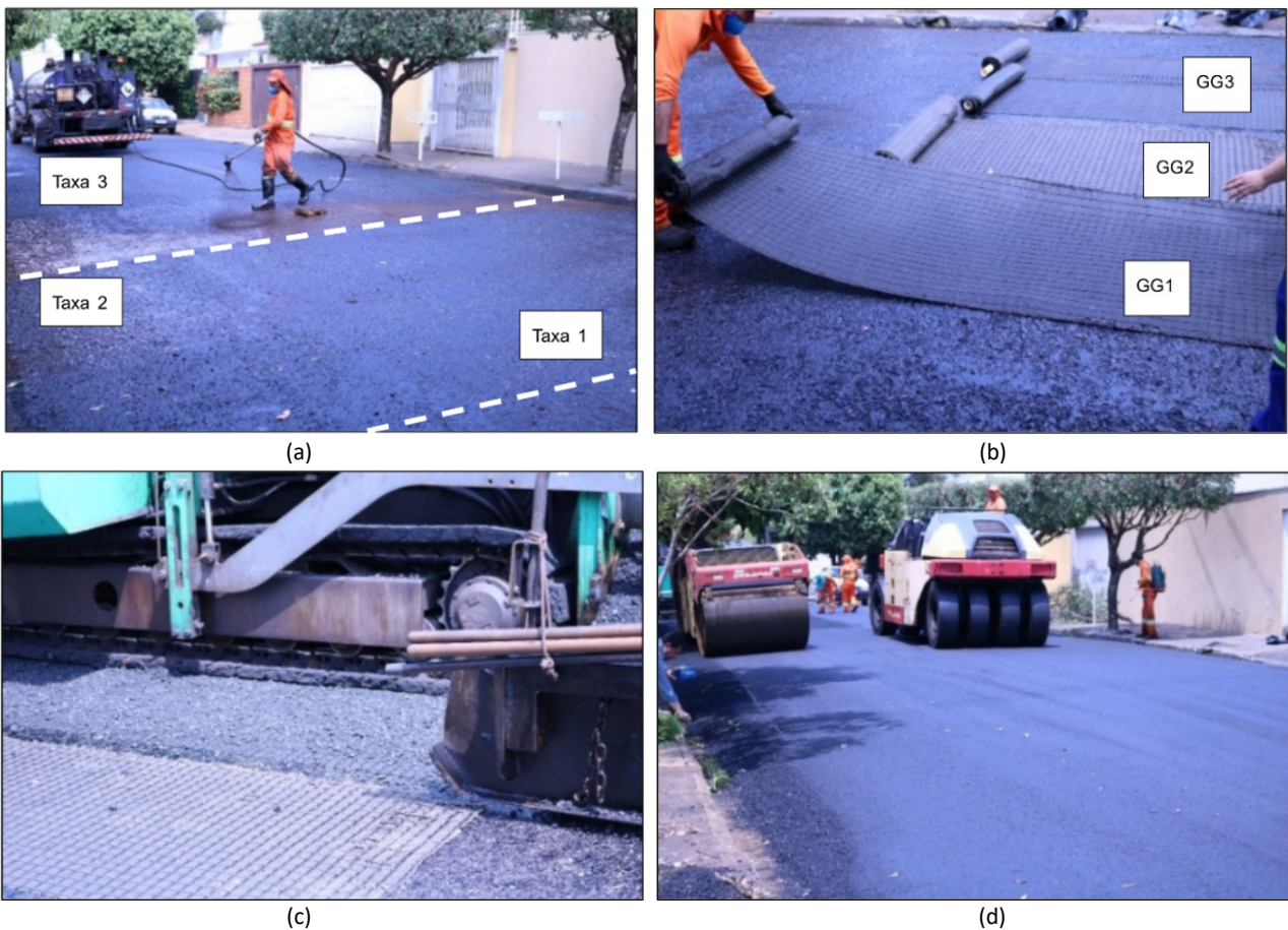
Figura 3. Instalação do trecho reforçado: (a) aplicação da emulsão; (b) instalação das geogrelhas; (c) aplicação do revestimento; (d) compactação
