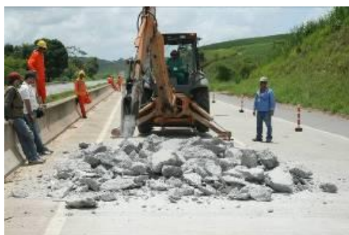
Figura 3- Avanço do trabalho de demolição
