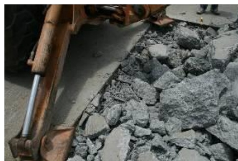
Figura 4- Placa rompida em blocos
