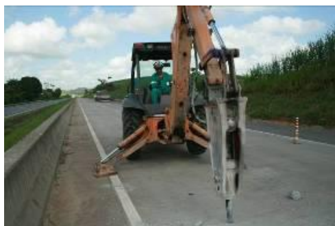
Figura 1- Início dos trabalhos de rompimento
